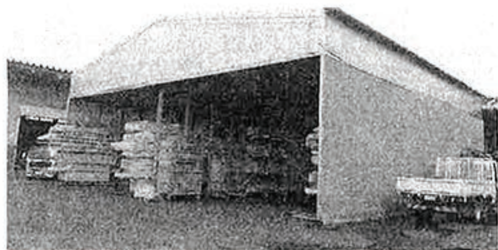
資材保管用に新設したラック
