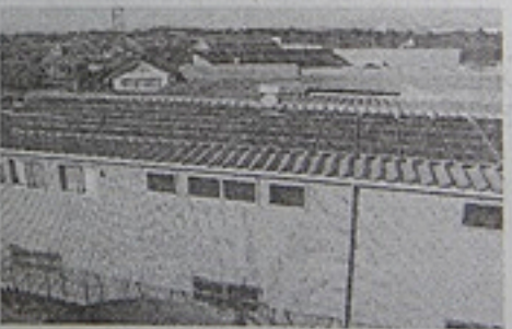
設置された太陽光パネル
