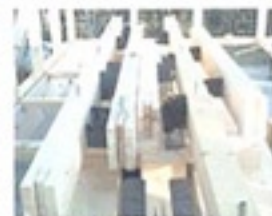
接合金物による プレカット 梁
